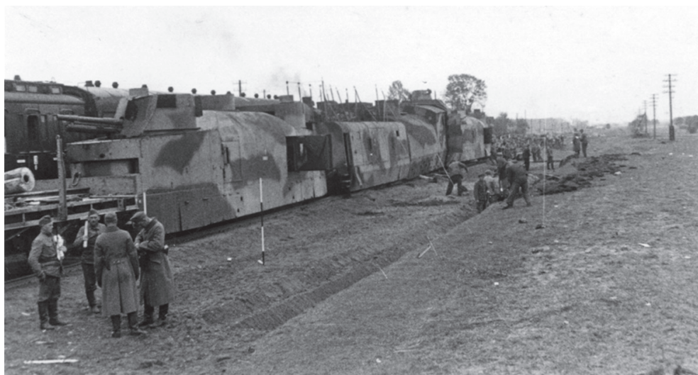
Fot. 4. Niemieccy saperzy przy budowie objazdu wokół „Pilsudczyka”. Fotografia pochodzi z kolekcji Pana A. Jończy.
